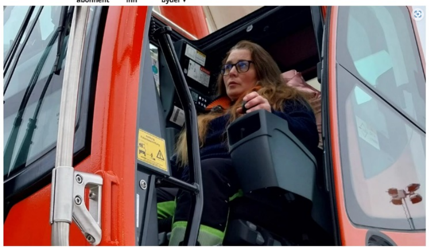
Siv Hege Barstad er kranfører, og har gjort seg sine første erfaringer med å operere en elektrisk kran på Dælenenga. Foto: Anders Høiland
